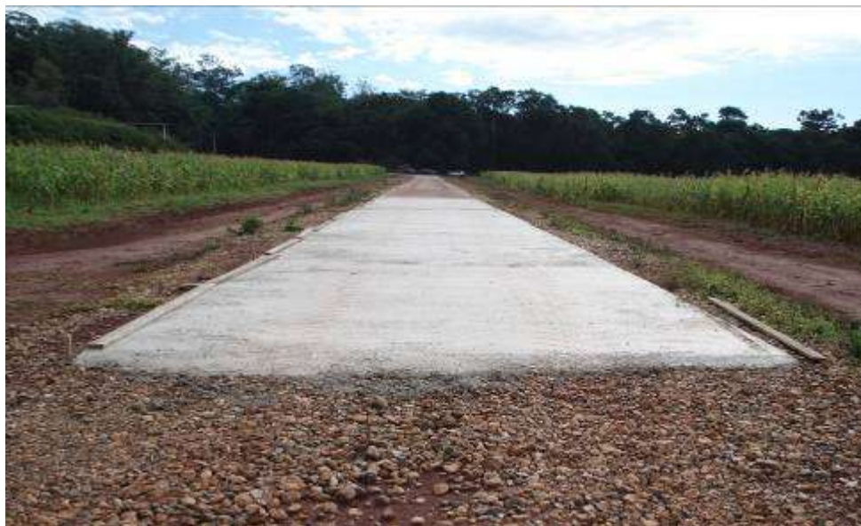
Figura 3 – Vista da pista de Concreto.
