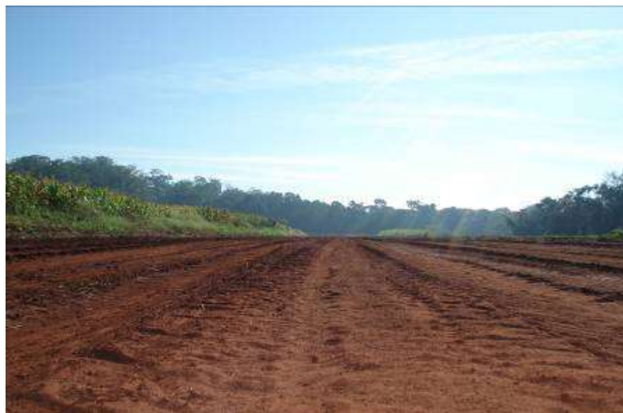
Figura 2 – Vista da pista de solo agrícola.
